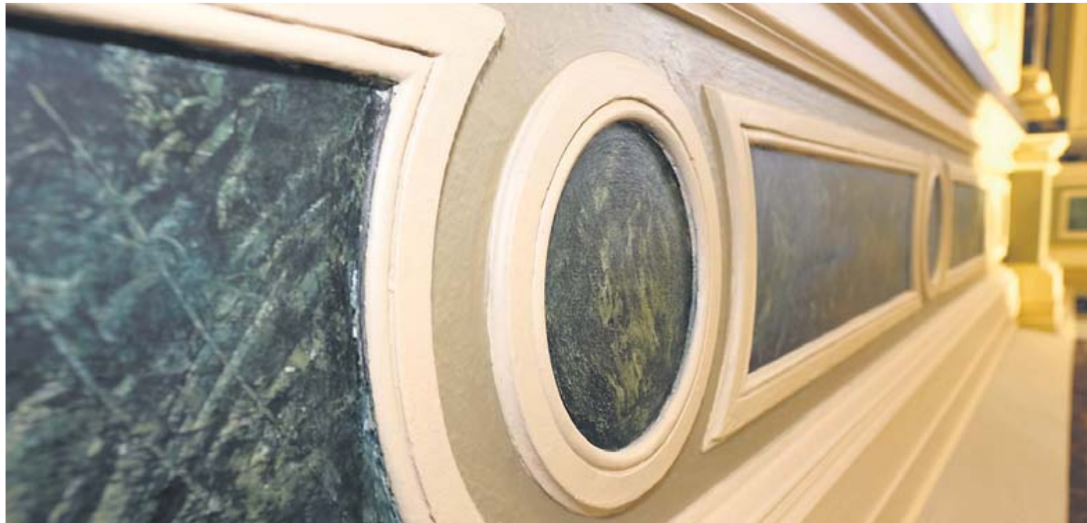
Blick auf das Stuckprofil eines umlaufenden Frieses mit marmorierten Feldern im Treppenhaus. Alles war unter einer dicken Latexschicht versteckt.
