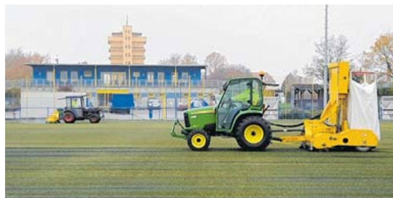
Der Kunstrasen auf dem Platz am Wasserturm wurde vor einiger Zeit wieder beispielbar gemacht. Zunächst wurde er mit einer Federzinkenfräse aufgelockert (hinten), dann wurde das Granulat aufgebracht und in einen großen Sack befördert (vorn) und später ersetzt.
