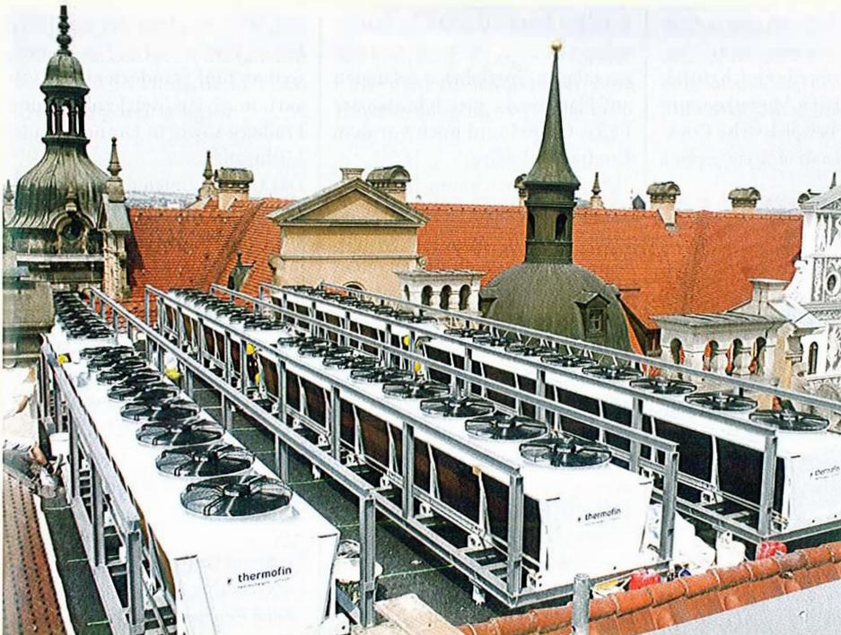
Auf dem Dach des Dresdner Schlosses sorgen seit Juni sechs Rückkühler von thermofin® für die richtige Temperatur und Luftfeuchte im Inneren des Gebäudes. Die Geräte sind Teil der zentralen Kälteanlage im Kälteverbund von Semperoper, Sempergalerie, Dresdener Zwinger und Dresdener Schloss. „Unsere Geräte weisen eine minimale Geräuschemission auf und sind sehr energieeffizient“, so Willy Löffler, Senior-Chef von thermofin®.
