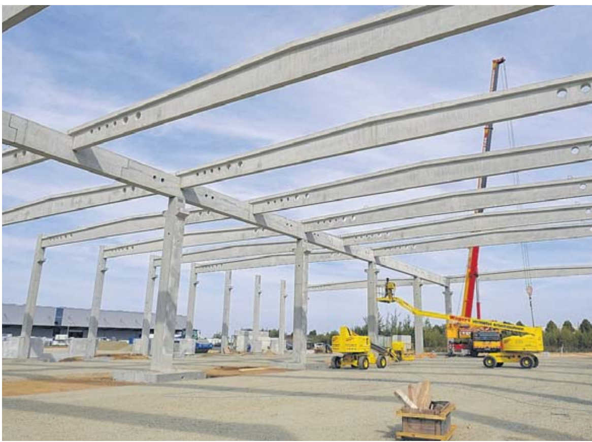
Der Bau im Industriegebiet an der A 72 kommt voran. Bereits im Februar soll die Logistikhalle in Betrieb gehen. Mit dem Neubau schafft Thermofin dringend benötigten Lagerplatz und optimiert Produktionsabläufe. FOTO: FRANKO MARTIN
