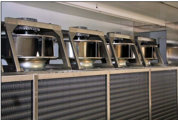
Anordnung der EC-Ventilatoren im Isolierkühler
